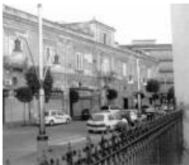
Fig. 19 - Il Palazzo Lupoli a Frattamaggiore
